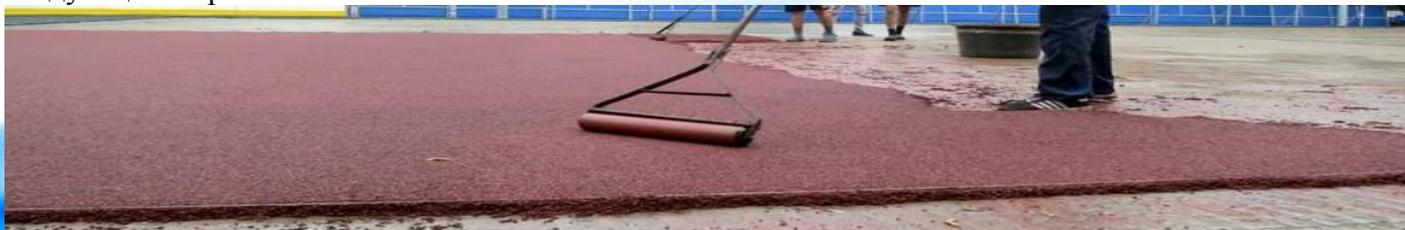
Изготовление бесшовных наливных покрытий на основе резиновой и каучуковой EPDM крошки является неотъемлемыми этапами, так как производство покрытия осуществляется непосредственно на объекте.
